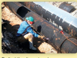
Radioaktiivselt saastunud torude puhastamine.
